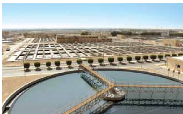
Рисунок 5 Общий вид на станцию «Манфуха» (Восточная).
